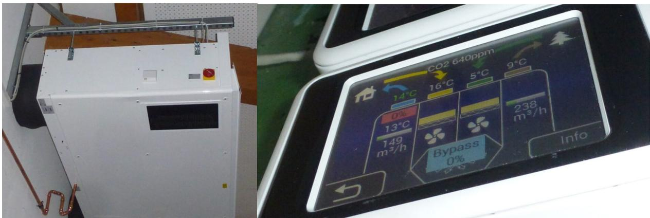
**Abbildung 11 Frischluftgerät SMG**
