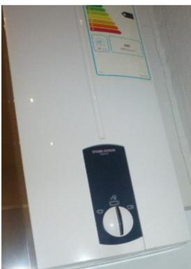
**Abbildung 105 Durchlauferhitzer ZHBB**
