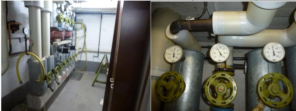
**Abbildung 50 Heizungsverteiler und Rohrleitungen KH3 GA**
