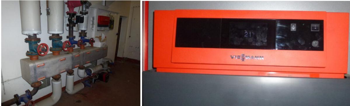
Abbildung 16 Heizungsverteiler BBS 1
