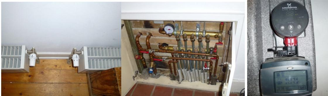
Abbildung 109 Heizkörper und FB-Verteiler
