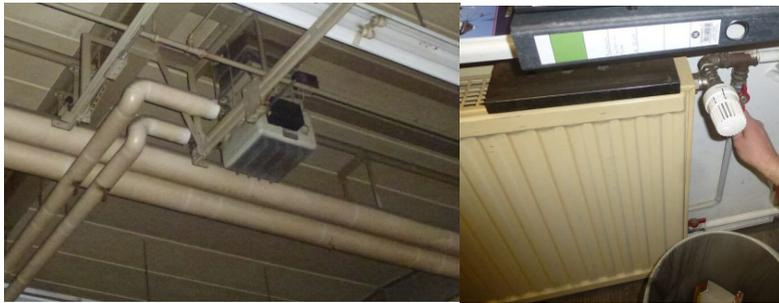
**Abbildung 81 Umlufterhitzer und Heizkörper SAG-Halle**
