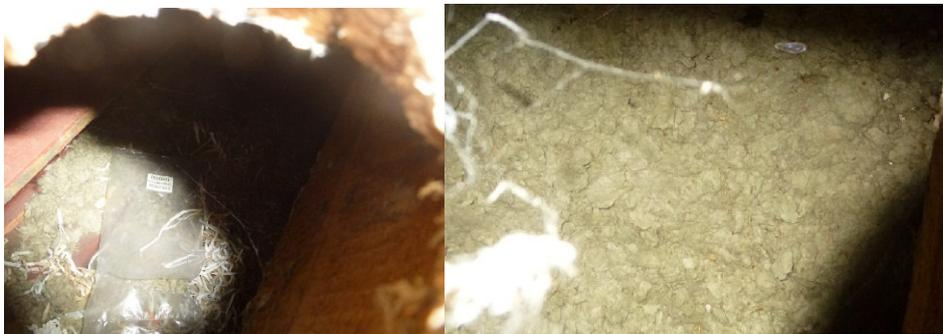
**Abbildung 40 Dämmung oberste Geschossdecke BBS2 AOS**
