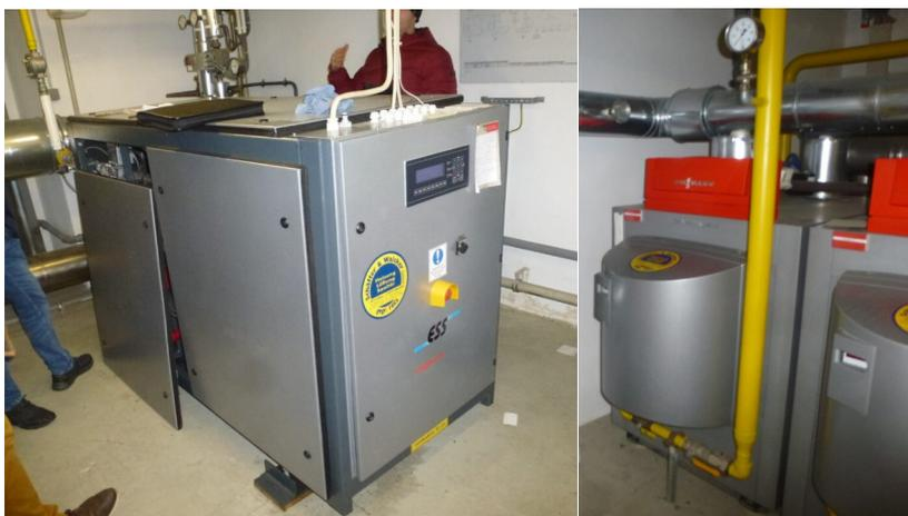
Abbildung 127 BHKW und Gasbrennwertkessel KH 3 SKG
