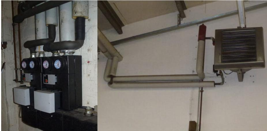
Abbildung 116 Heizkreise und Umlufterhitzer KSM N
