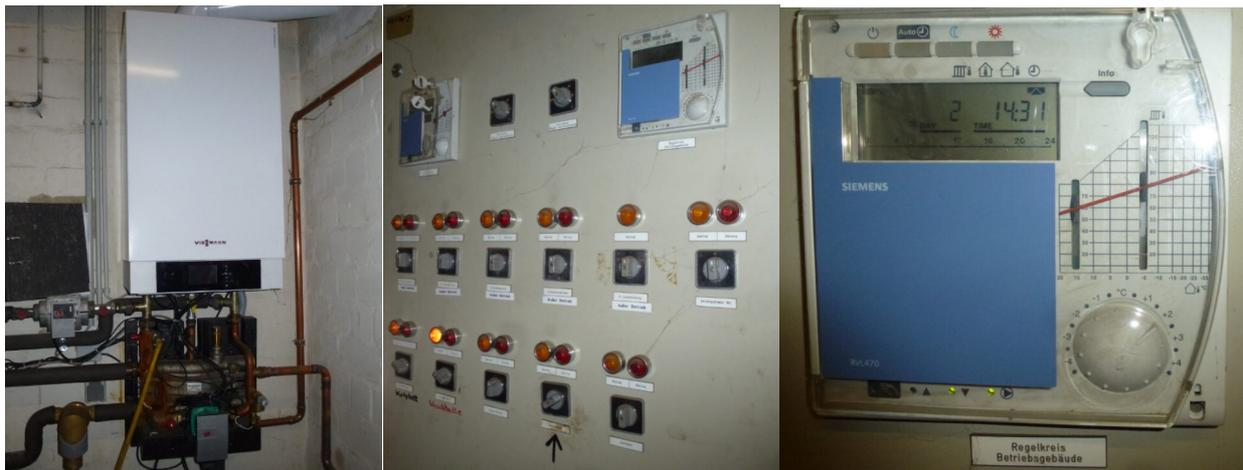
Abbildung 115 Wärmeerzeuger und Steuerung KSM N
