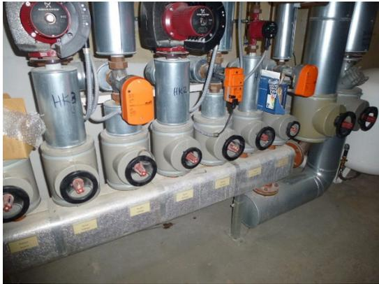
**Abbildung 27 Heizungsverteiler BBS 2 MS**
