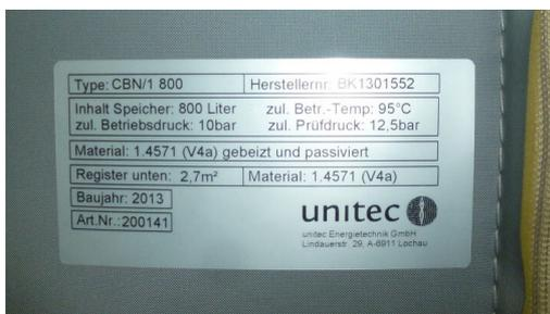
**Abbildung 94 Typenschild Warmwasserspeicher**
