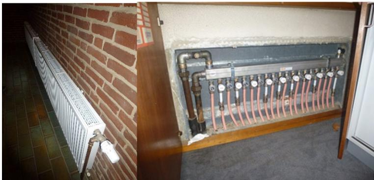
**Abbildung 58 Heizkörper und FB-Verteiler SVA**
