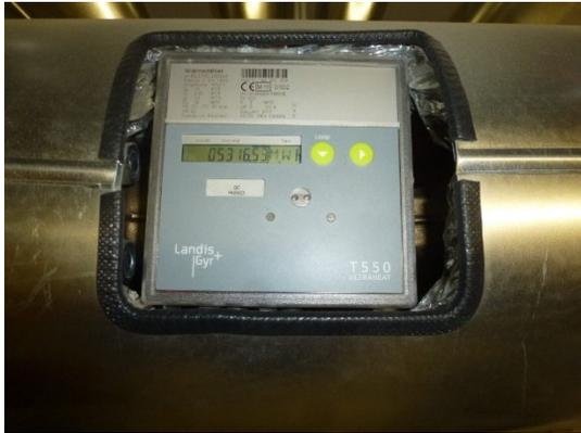
**Abbildung 128 WMZ in Rohrdämmung KH3 SKG**
