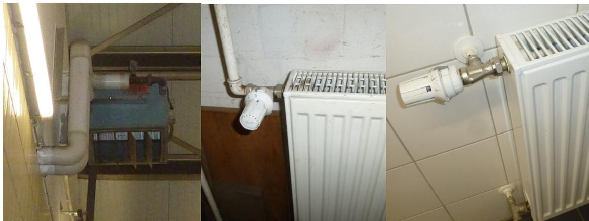
**Abbildung 121 Umlufterhitzer und Heizkörper Werkstatt, Halle und Duschen KSM S**
