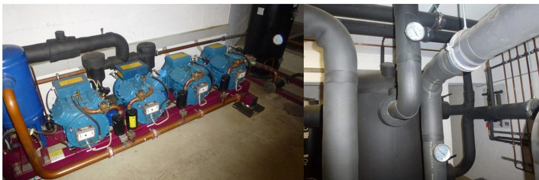
**Abbildung 130 Kälteanlage und Pufferspeicher KH3 SKG**
